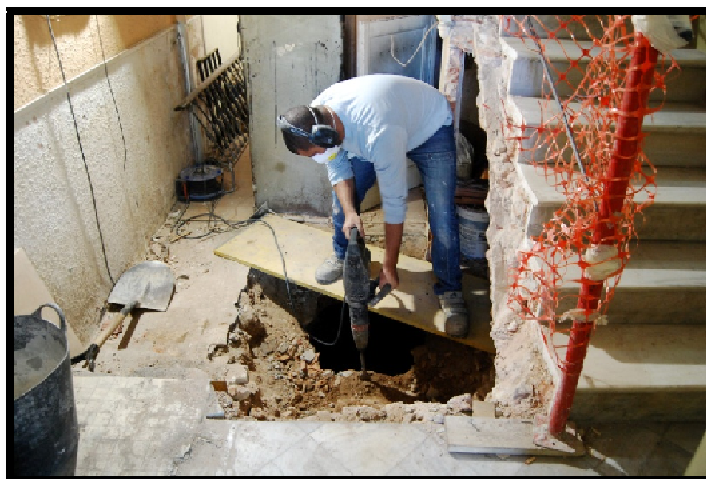
Foto 2. Excavació manual del sondeig.
